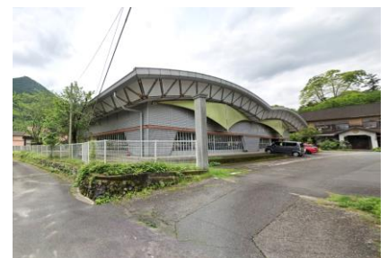
解体されるスパーク耶馬溪（平田）
