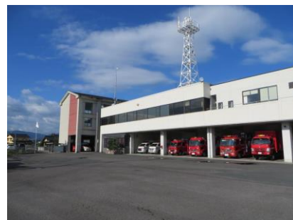
築 49 年を経過した消防本署
