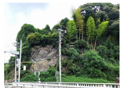
崩落危険箇所（洞門入口交差点）
