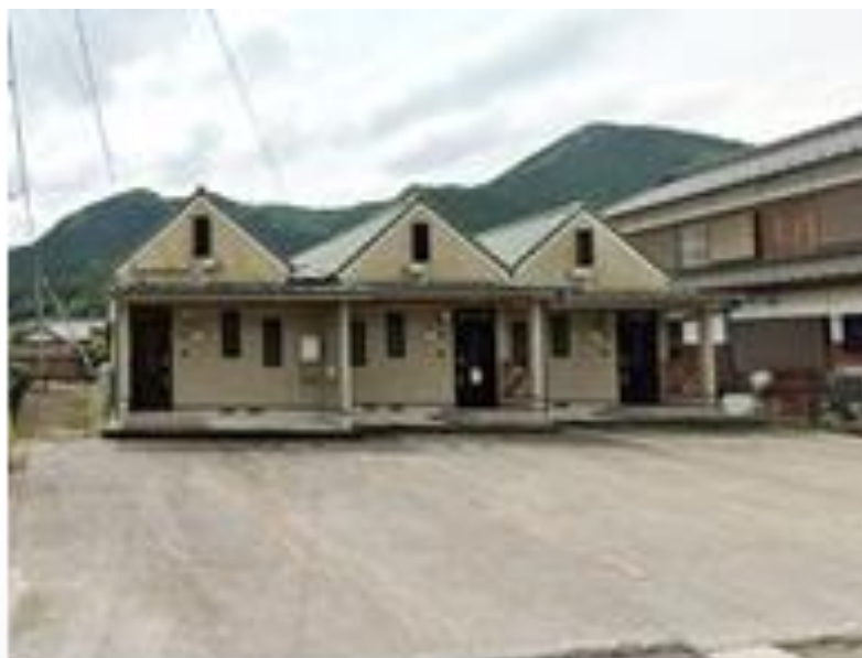
学生寮に改修される平田教職員住宅
