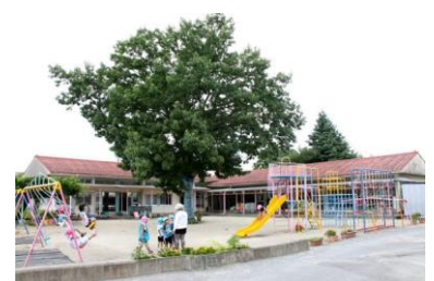
老朽化した大幡幼稚園
