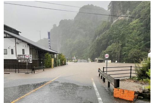
7月豪雨 青地区の浸水状況
