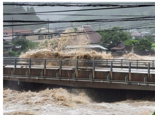
荒れ狂う山国川（耶馬溪町城井橋）
