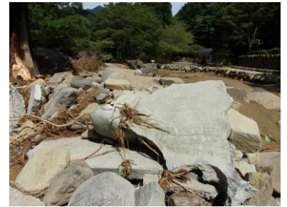
被災した山国河川プール
