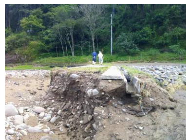
耶馬溪町妙ヶ野地区農道・水路
