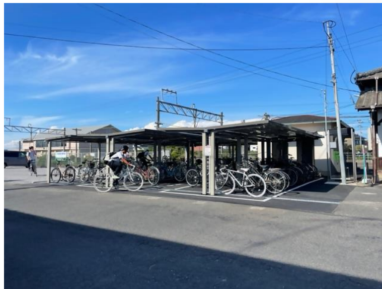
整備された東中津駅駐輪場
