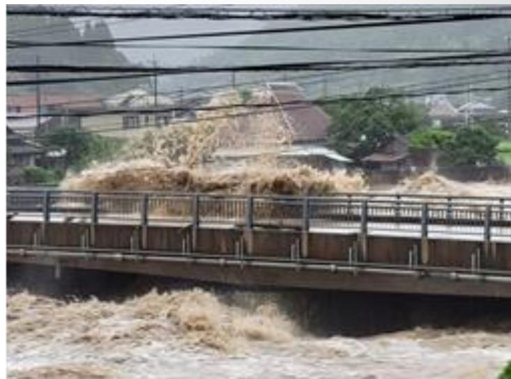
荒れ狂う山国川（耶馬溪町城井橋）
