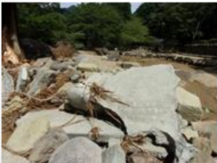
被災した山国河川プール
