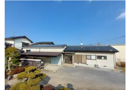
自宅の太陽光パネル
