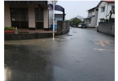
8月に冠水した一ツ松の道路
