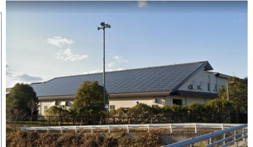
中津市清掃センターの太陽光パネル
