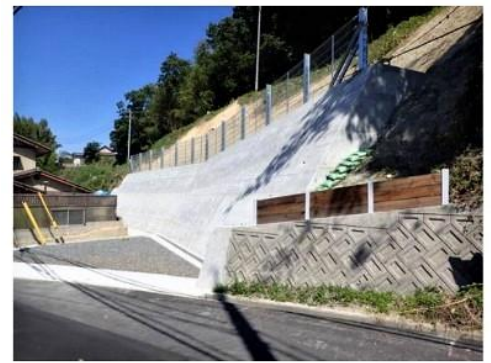
急傾斜地崩壊対策事業
