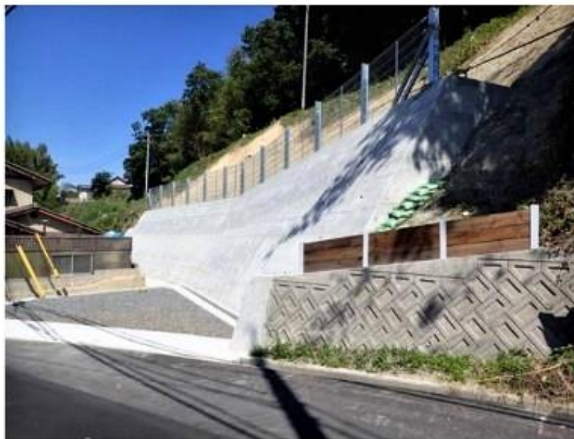
急傾斜地崩壊対策事業
