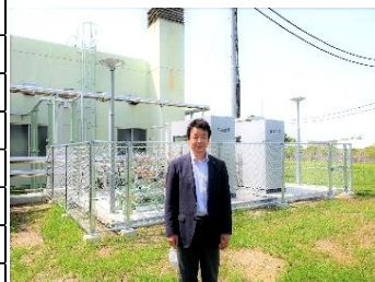
消化ガス発電施設現地調査
