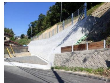
急傾斜地崩壊対策事業
