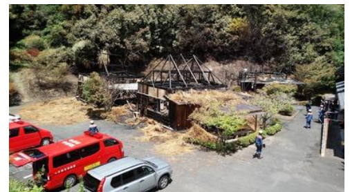
火災の起きた西谷温泉宿泊施設
