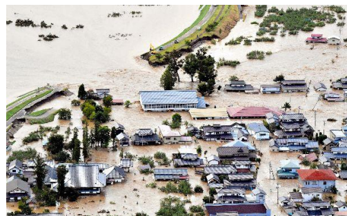
千曲川の堤防が決壊し、浸水する住宅
