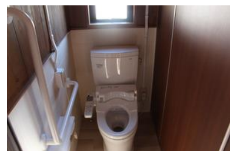
改修された北部公民館のトイレ
