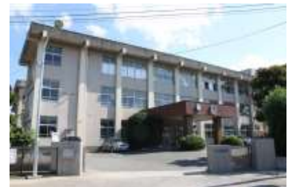
大規模改修が実施される鶴居小
