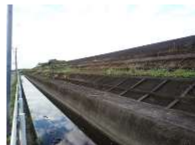
改修される防潮堤（新大塚）
