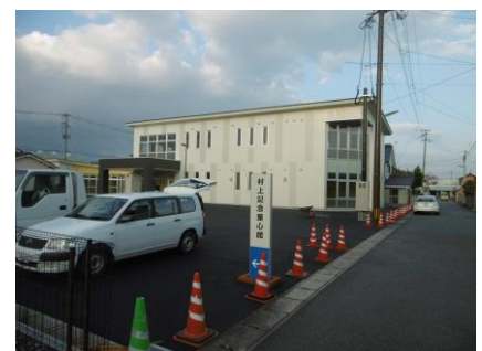
外構工事中の村上記念童心館
