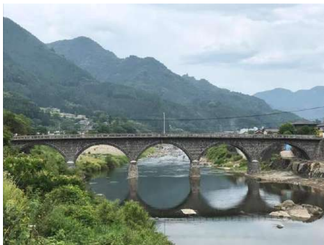
災害復旧工事の終わった馬溪橋（耶馬溪町平田地区）
