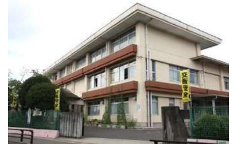
大幡小学校校舎
