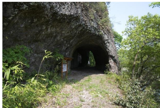
山国町のツツ戸隧道
