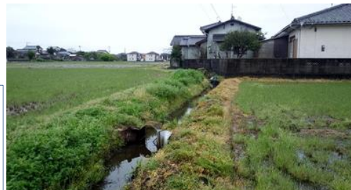
工事が中断した間無地区の水路
