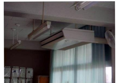
全ての小学校にエアコンを設置
