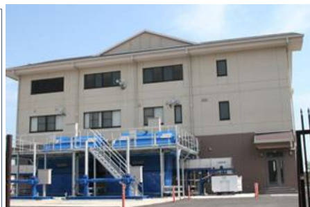
米山雨水ポンプ場
