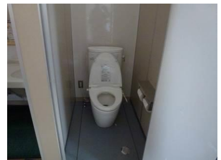
改修された北部小学校のトイレ
