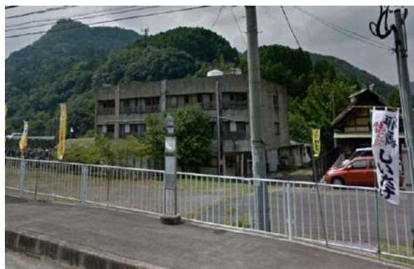
解体される耶馬溪中学校寄宿舎
