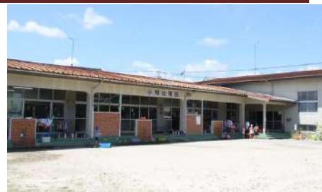
改修される小楠幼稚園
