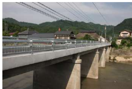
仮復旧した雲與橋（下郷地区）
