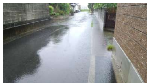
冠水した道路(大塚町)
