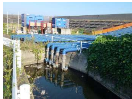
角木の仮設ポンプ場
