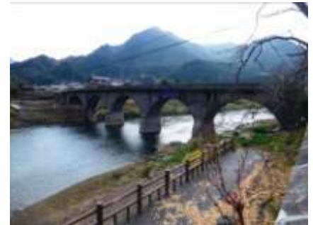
通行止めとなっている馬溪橋
