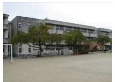
耐震補強工事を行う沖代小学校
