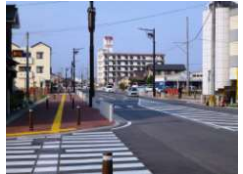
駅北口の街路樹のない市道
