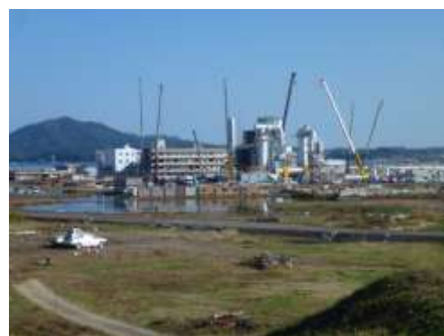
気仙沼市に建設中のガレキ処理工場
