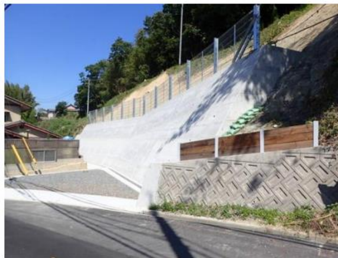
急傾斜地崩壊対策事業
