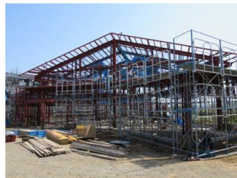
レストラン建設工事
