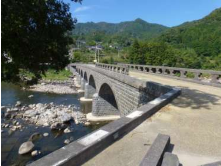
本耶馬溪町 耶馬溪橋(オランダ橋)
